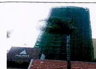
Figura 18 Foto do Aero Espaço Empresarial & Hotel em construção
