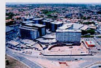
Figura 16 Foto do Hangar Business Park em construção.
