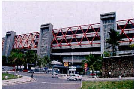
Figura 19 Centro de Convenções do Estado da Bahia
