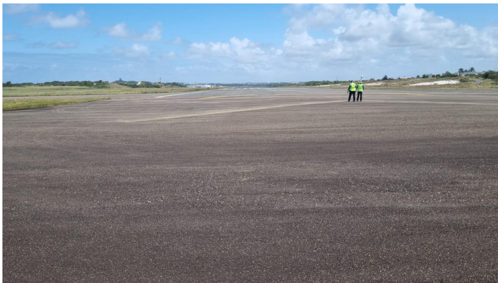
Figura 2 – Pista de Pouso e Decolagem Principal
