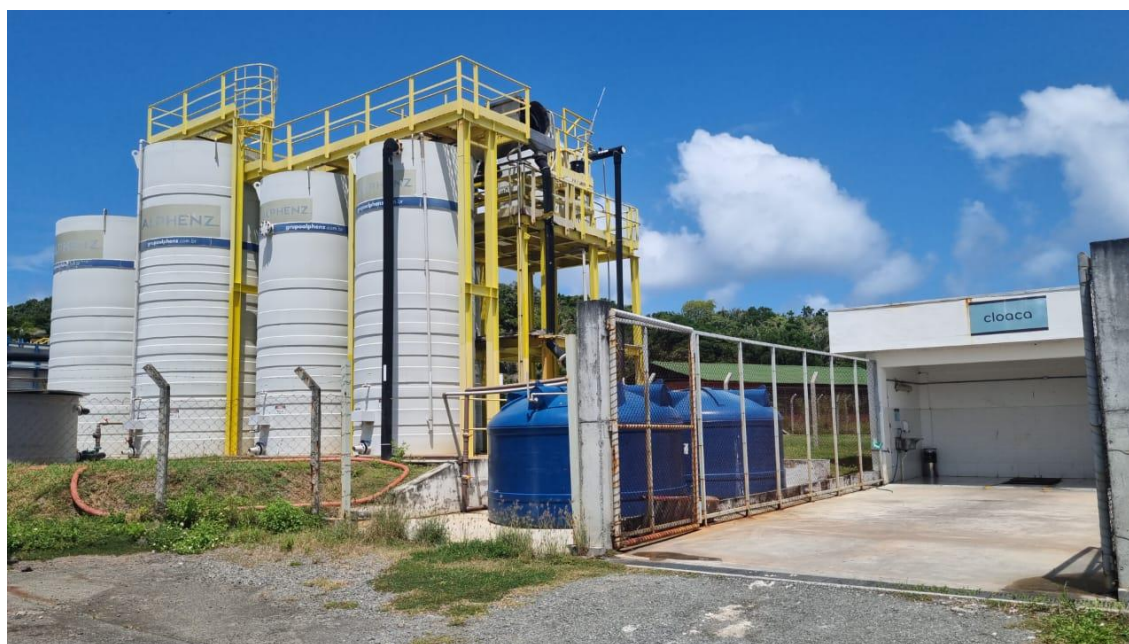
Figura 22 – Estação de Tratamento de Esgoto (ETE)
