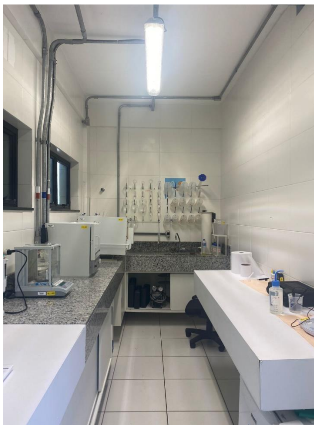
Figura 21 – Estação de Tratamento de Efluentes
