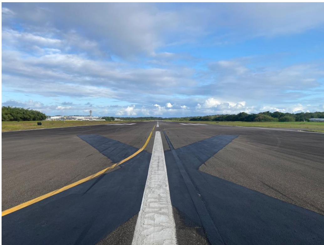
Figura 3 – Pista de Pouso e Decolagem Secundária
