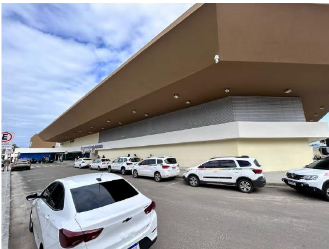
Figura 3 – Terminal de Passageiros
