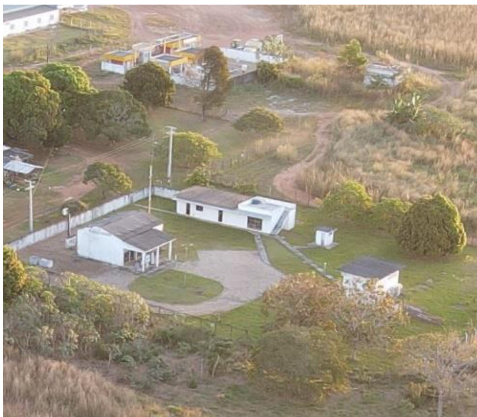
Figura 5 – Instalações de Estação Meteorológica Automática (EMA)
