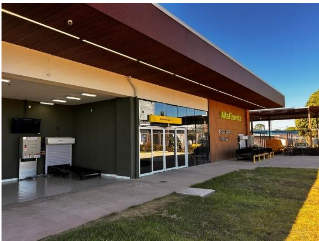
Figura 3 – Vista frontal do Terminal de Passageiros
