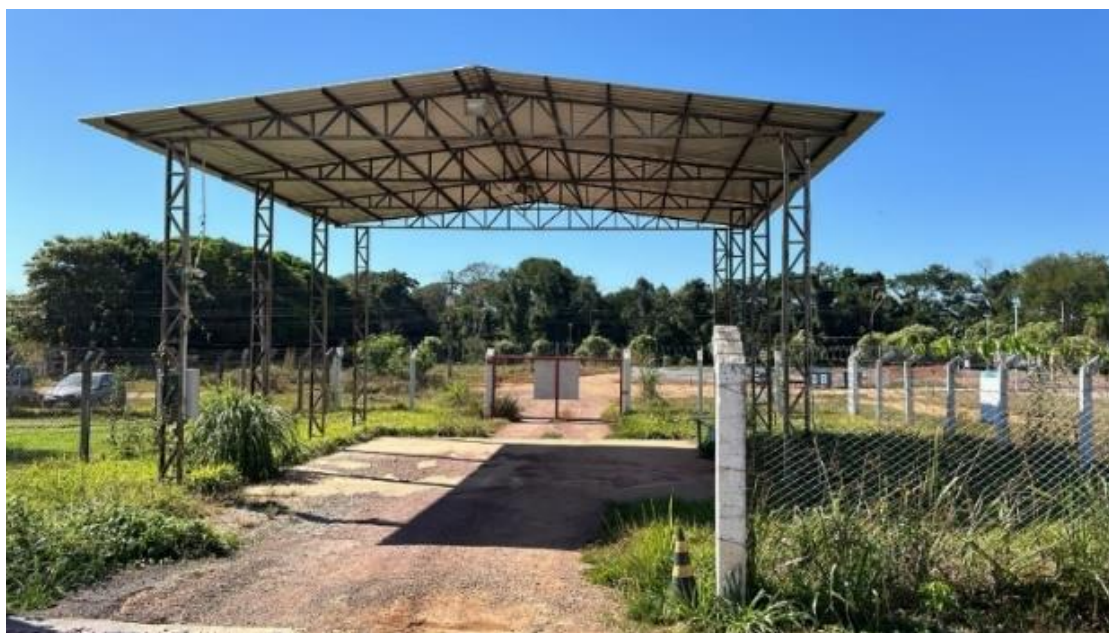
Figura 6 – Canal de inspeção P1
