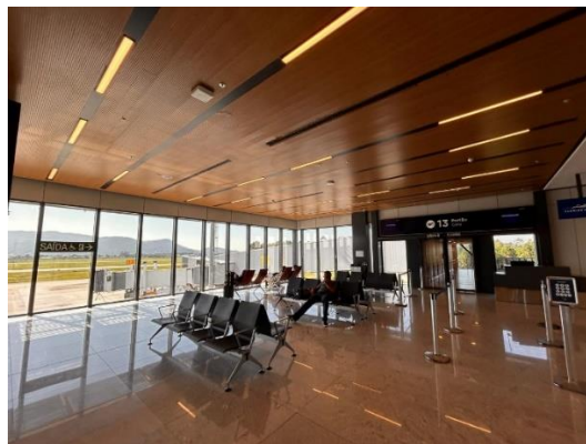
Terminal de Passageiros
