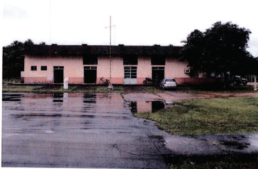
Figura 27 - Aeroporto de Oiapoque - lado AR
