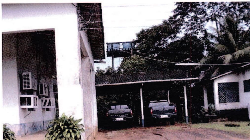
Figura 4 - Reservatórios elevados do DTCEA
