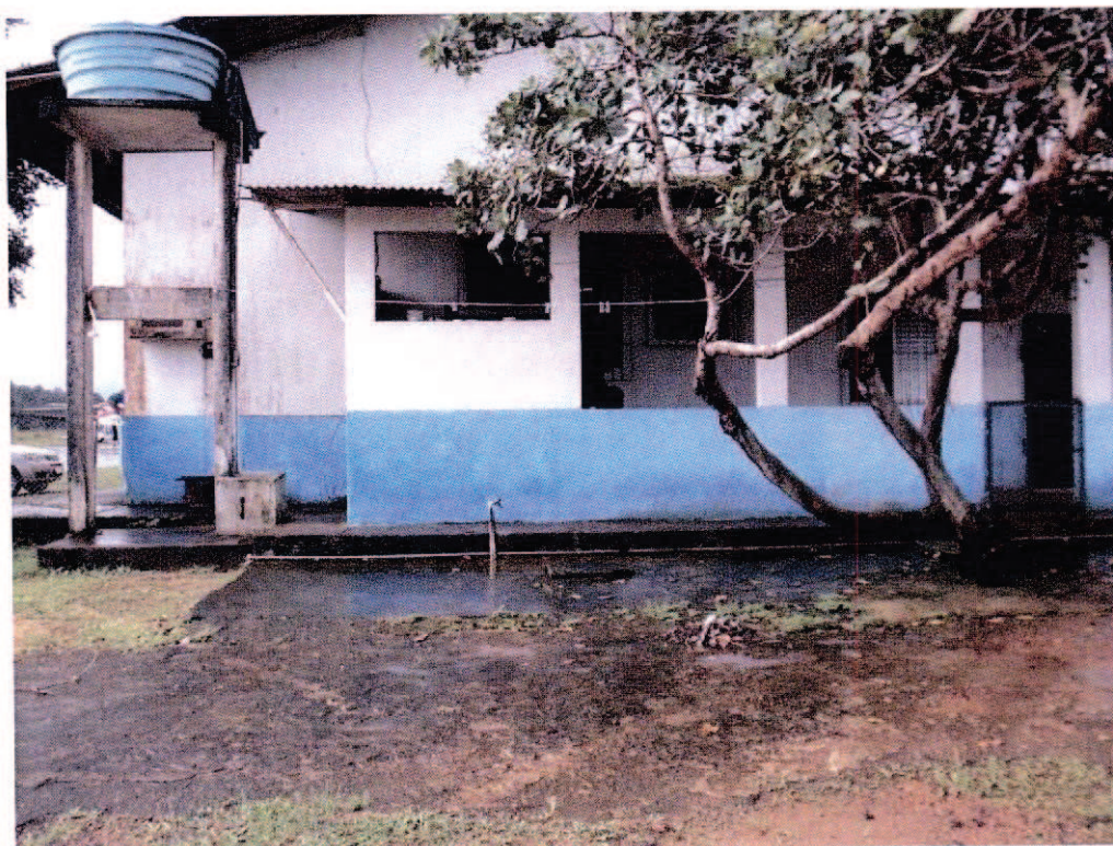
Figura 3 - Reservatório elevado do TPS
