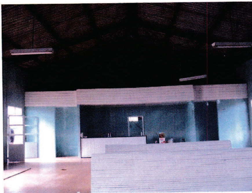
Figura 29 – Saguão com vista da lanchonete e porta da cozinha e entrada dos sanitários
