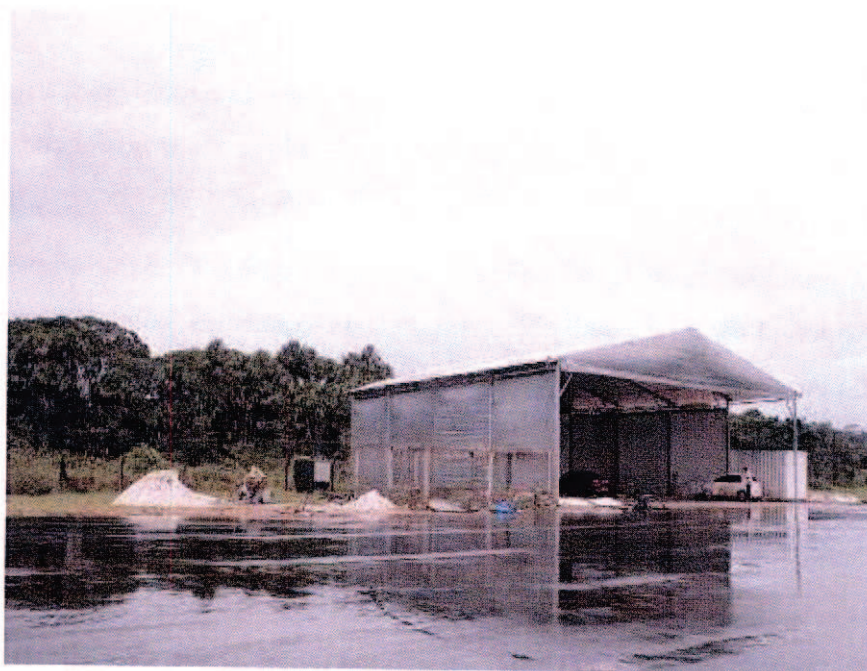
Figura 23 - Área de obras do hangar provisório da Petrobras
