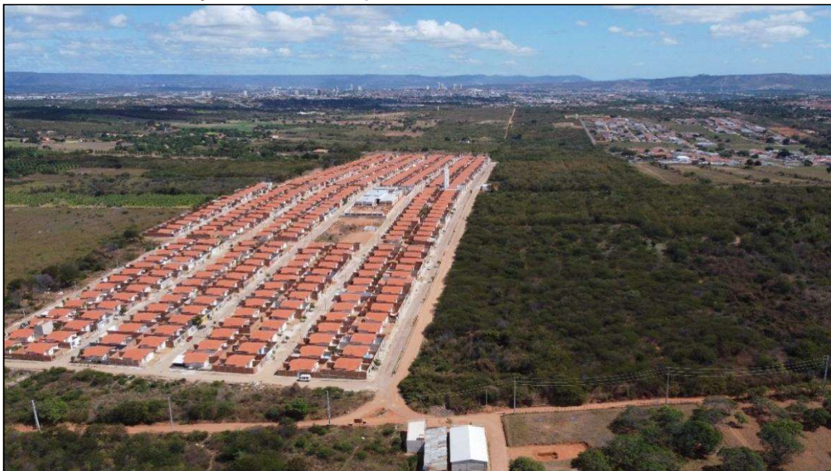
Figura 17: Juazeiro do Norte - CE: Isolamento do conjunto habitacional padre Cícero do restante da cidade
