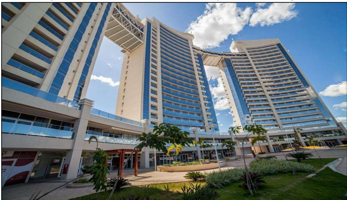
Figura 13: Juazeiro do Norte - CE: Verticalização no bairro Triângulo
